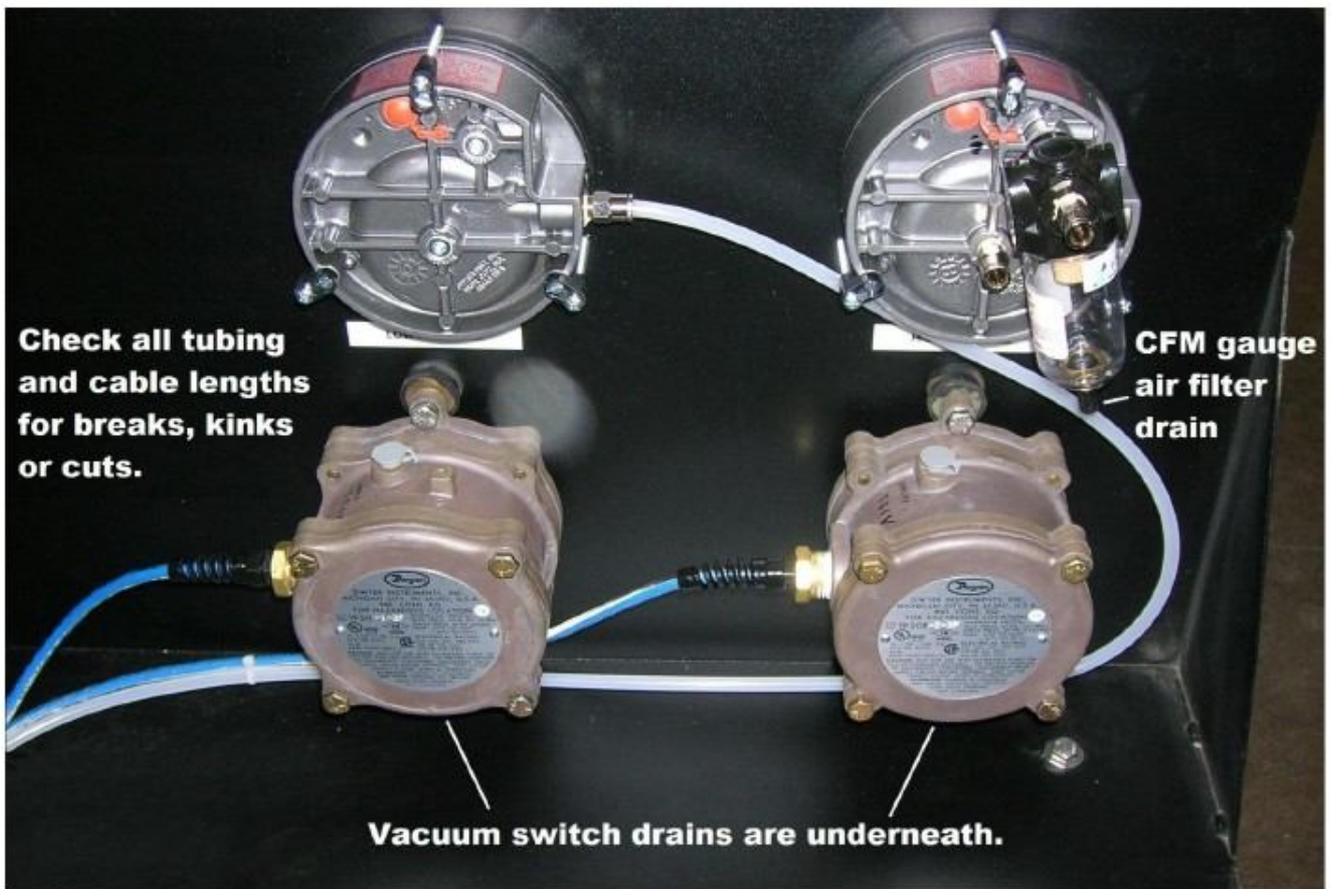
图 4-4 静态压力传感器，压力开关之间的软管连接（没有显示CFM流量表）
