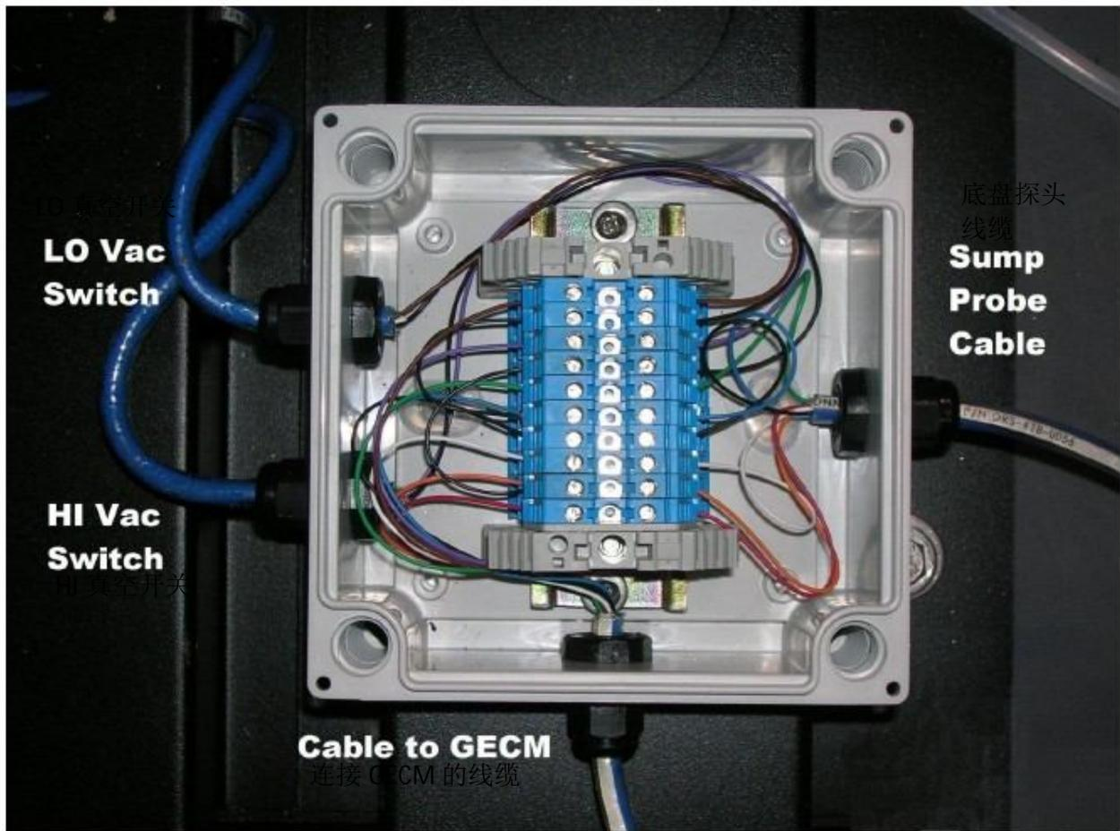
图 2-3 LO-PRO III接线盒和HI/LO真空开关，底盘探头以及GECM控制面板的连接示意图
